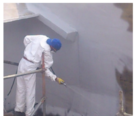
Applikation der Beschichtung PROGUARD CN 200
