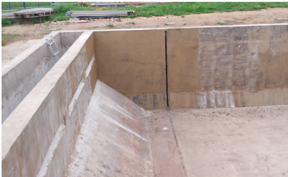
Sanierte Beckenkronne, Applikation der Grundierung
