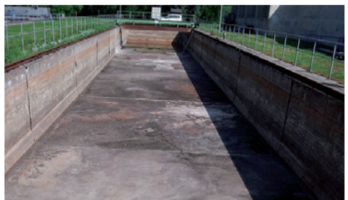
Pufferbecken vor der Sanierung
